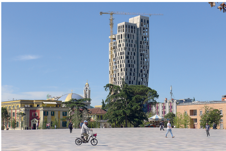
Het in 2017 opgeknapte Skanderbegplein, met uitzicht op de 4Evergreen-toren in aanbouw.
