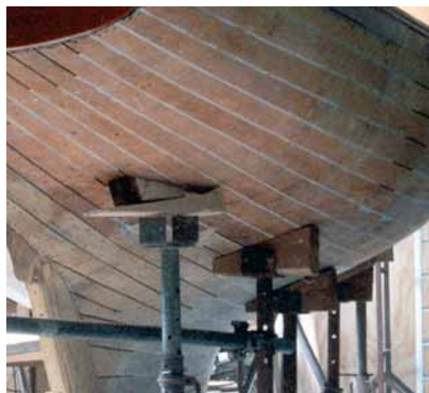
Opvullen naden met houten lat en epoxylijm. Ook schroef- of spijkergaten worden zo gevuld.
